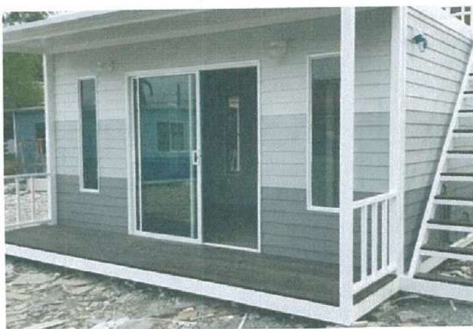
บ้านประกอบเสร็จ
